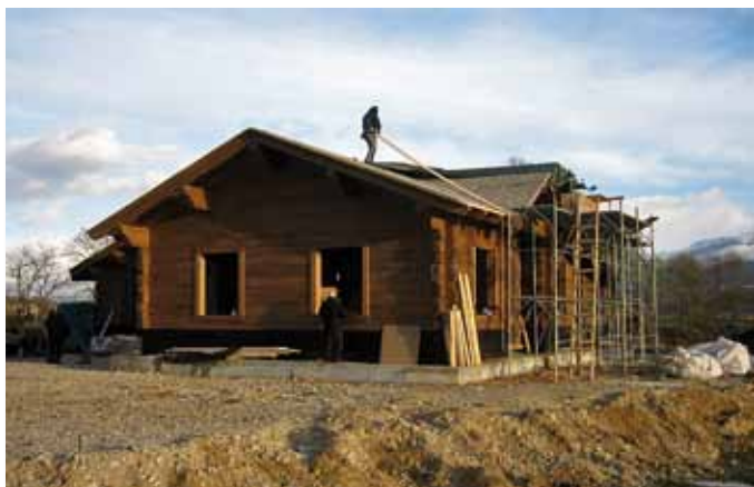
Il magnifico prefabbricato in legno in via di ultimazione da parte del Comune di Livigno nel Comune di Stiffe (dove fungerà da centro visitatori, biglietteria e ristoro, per le visite alle rinomate omonime grotte che prima del terremoto accoglievano più di 80 mila visitatori all'anno)
