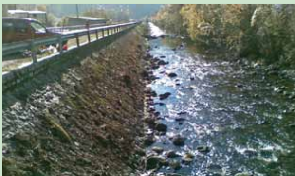
Le fasi dell'intervento di PC sul torrente Poschiavino a Tirano
