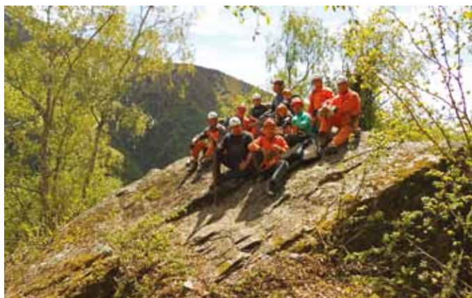
I volontari del Gruppo impegnati in interventi manutentivi.
