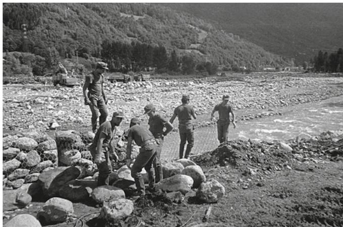
Vengono predisposti gabbioni con cui gli Alpini avranno modo di familiarizzare durante le operazioni di soccorso. Costruiti in rete metallica hanno la capacità di due metri cubi e vengono riempiti con pietre accuratamente incastrate con un estenuante lavoro di passamano.
