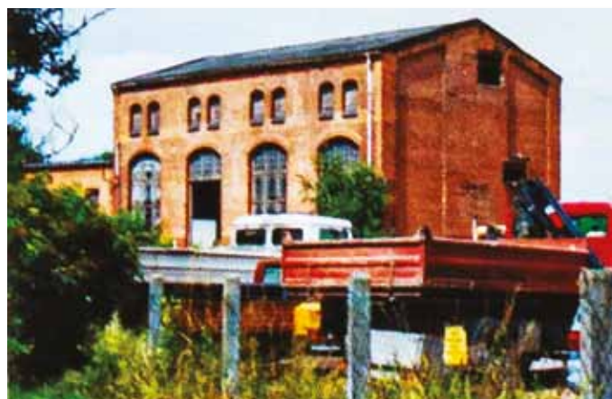
Edificio comando ascensore pozzo minerario
