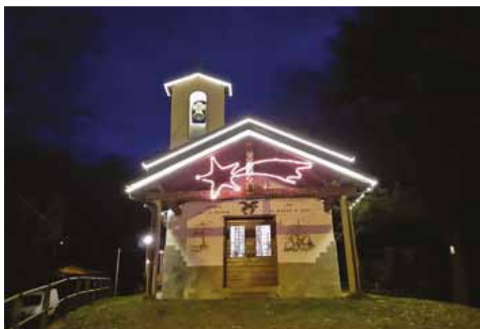
Vari interventi manutentivi al Tempietto operati dalle penne nere del Gruppo talamonese.
