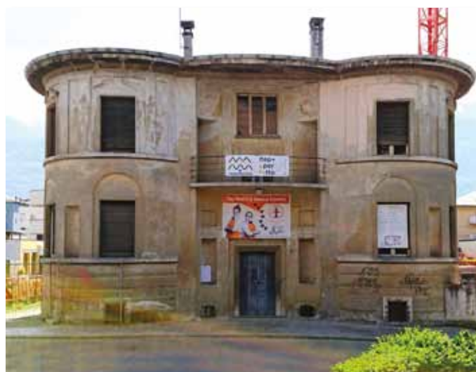
Il cantiere nel centro di Sondrio, a pochi passi da Piazza Garibaldi.
